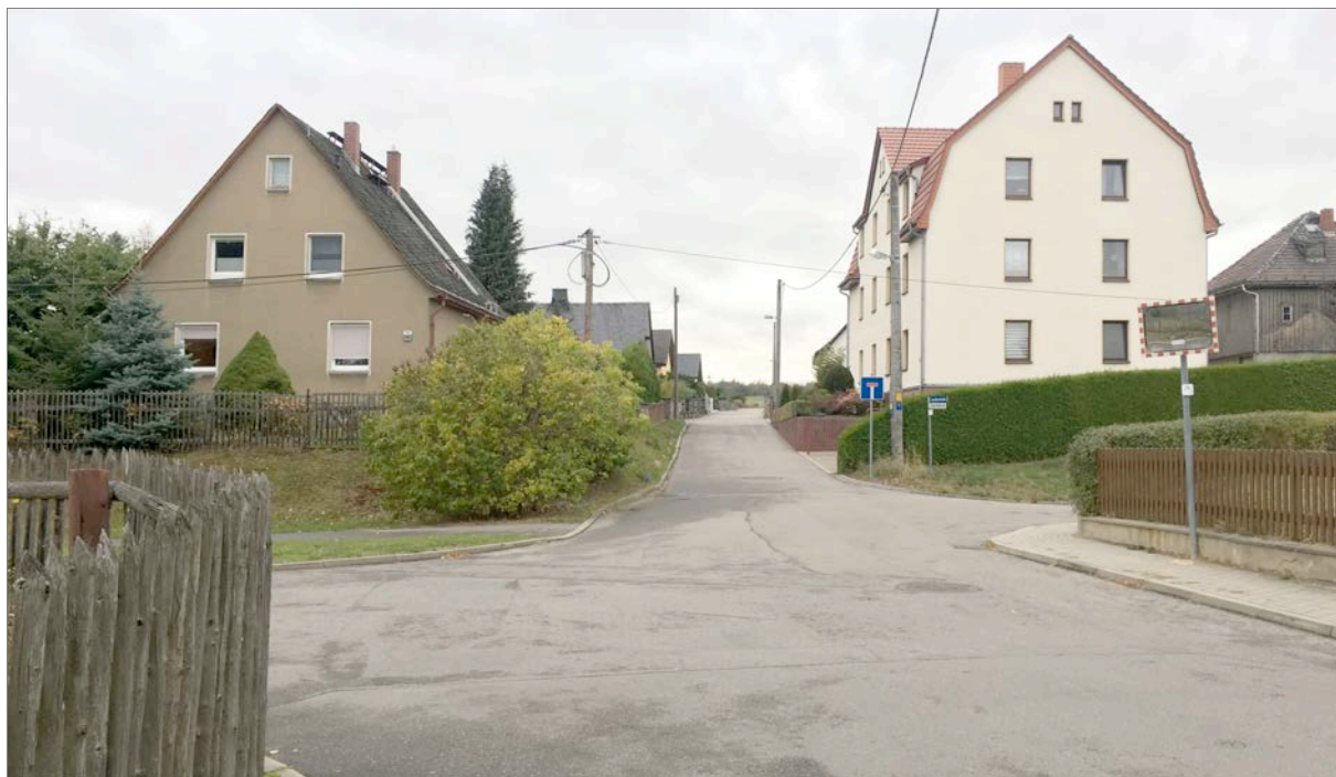
Blick nach West über den Kreuzungsbereich Jacobusstraße / Ernst-Schneller-Straße in den kurzen Straßenabschnitt der Ernst-Schneller-Straße - AST 1, der zur Ergänzungsfläche führt. Rechts die Einmündung in die Jacobusstraße, links der weitere Verlauf der Ernst-Schneller-Straße. (Oktober 2018)
